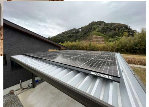
※屋根に穴を空けず、カーポートの屋根設置です。
