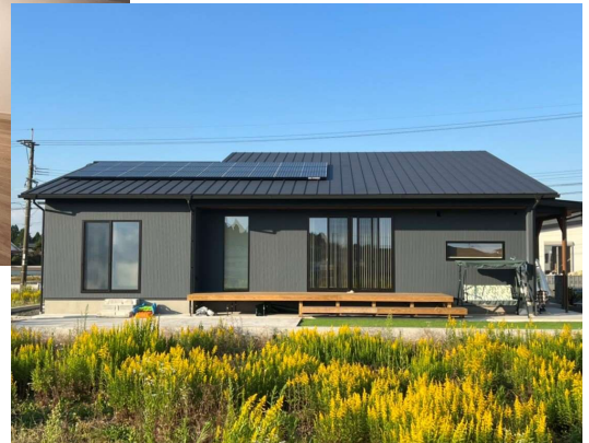
※太陽光は屋根に穴を空けない工法
